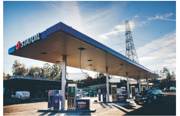
SNABBA RYCK. Den nya macken vid Vårby har satts upp i rekordfart efter sommaren, en del av arbetet med Förbifarten. FOTO: JOHANNES LJLJESON
